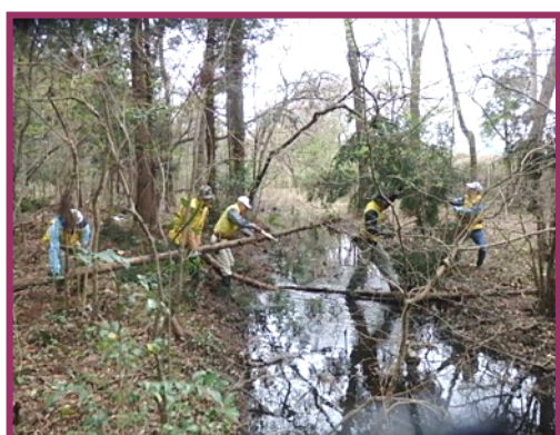
伐採スギを活用して応急木橋を架設 （作業中 2019/3/23）
