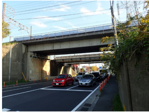
常磐線の架道橋
