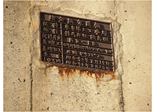
常磐緩行線の銘板
