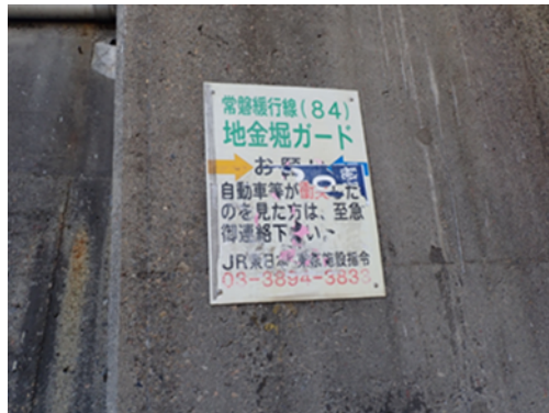
地金堀ガードでのトラブル時の連絡看板
