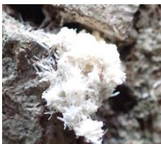
穿入孔を取り囲む粗いフラス（写真では半分脱落）は、最初に雄が穿入し出したフラス。
